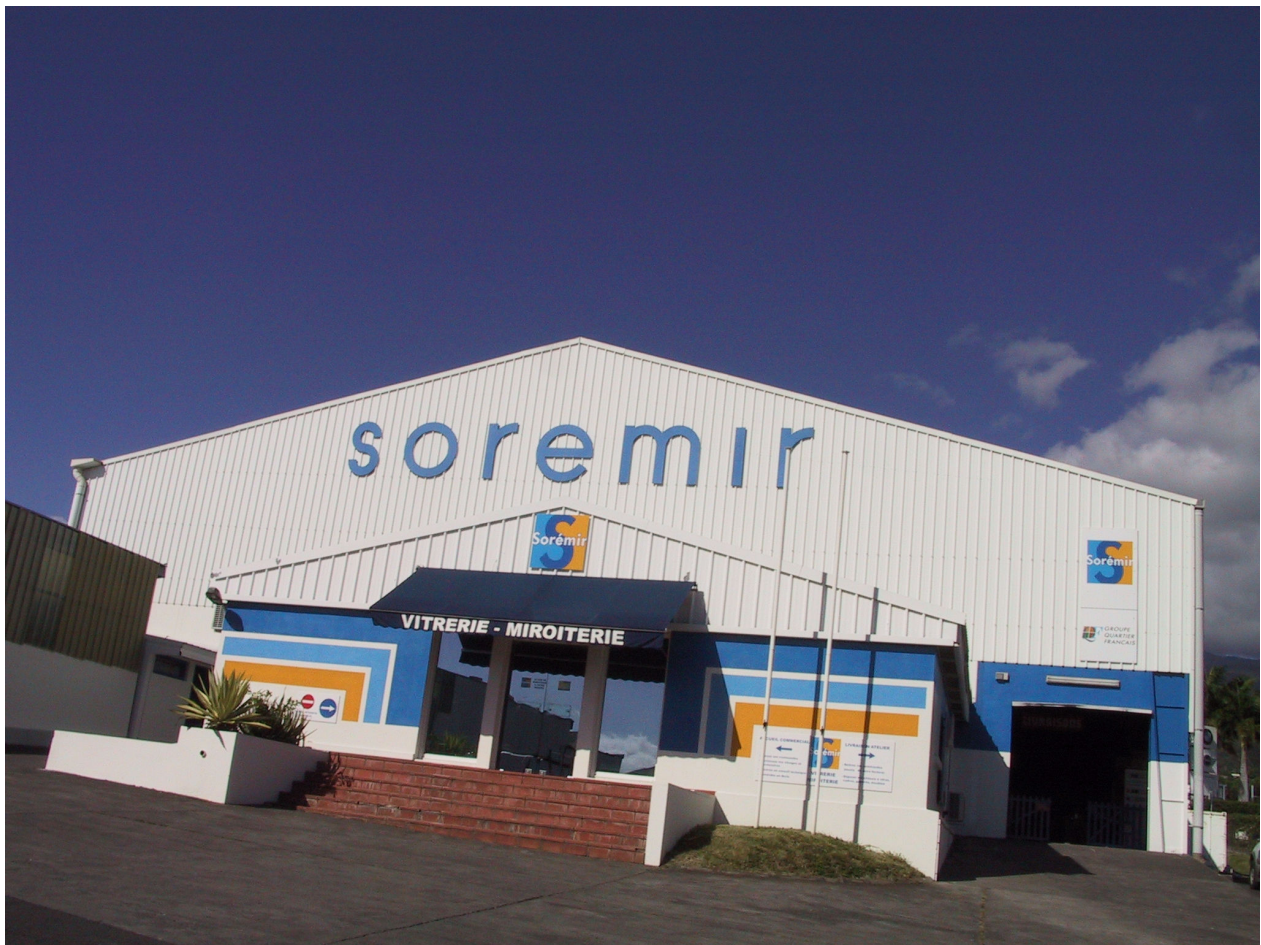
SOREMIR (Société Réunionnaise de Miroiterie) à Saint-Denis, sur l'île de La Réunion (Façade_SOEMIR.jpg)
